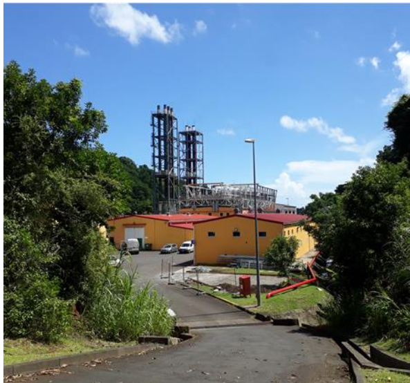
Centrale de Longoni
